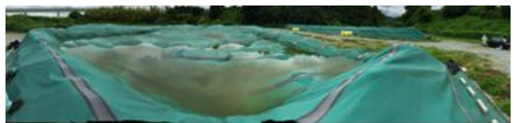
図1 キャッピング上部に生成した雨水溜まりの様子
