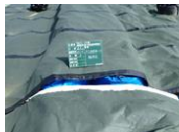
図2 破損事例(接合部の剥がれ)
