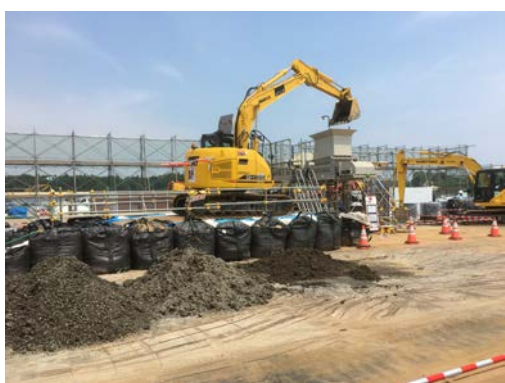
写真 南相馬市における土壌の再生利用実証事業の様子（左は異物除去した土壌を濃度分別機に投入する様子、右は土壌の盛土施工工事の様子）
